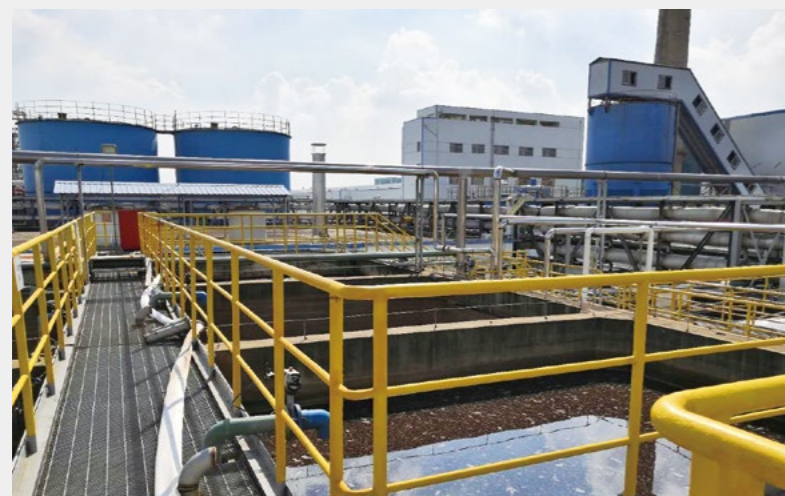
改造前： 钢筋水泥、管道纵横
